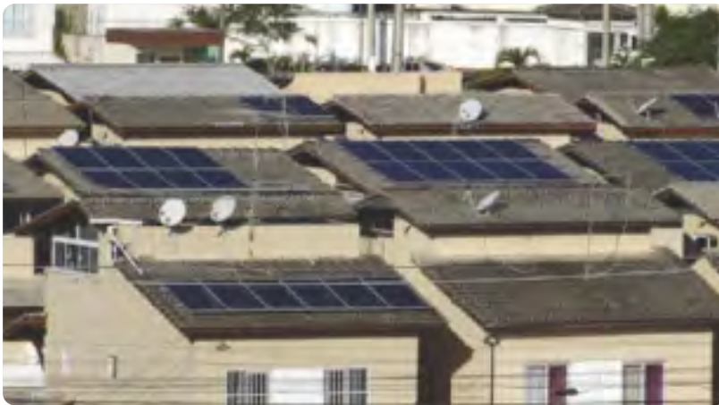
Casas com painéis solares nos telhados, em Salvador (BA), 2020.
